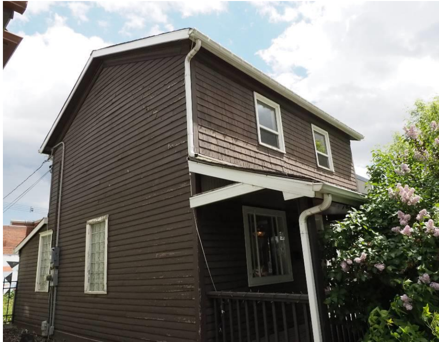
(Image 2.2 – West façade)
