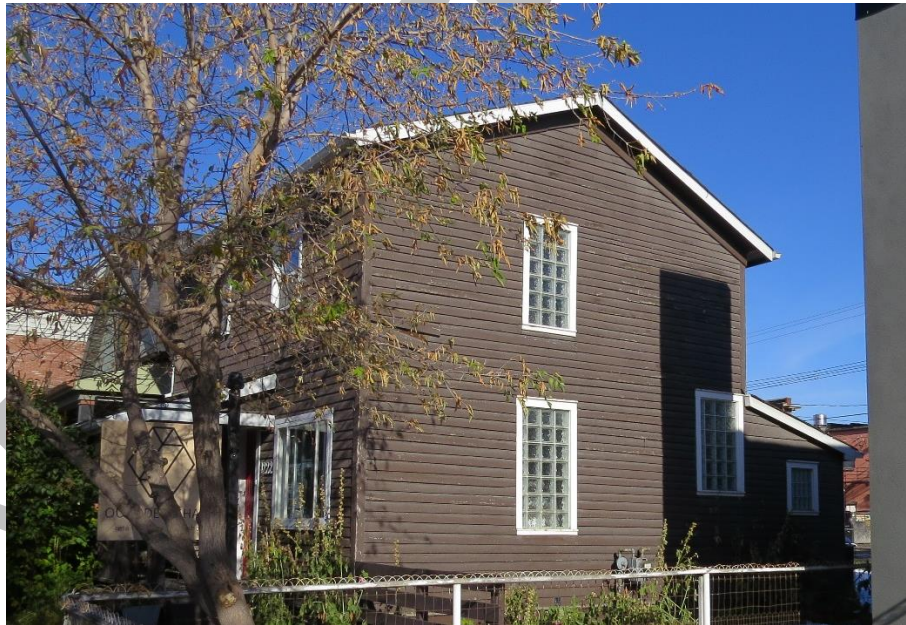
(Image 2.3 – East façade)
