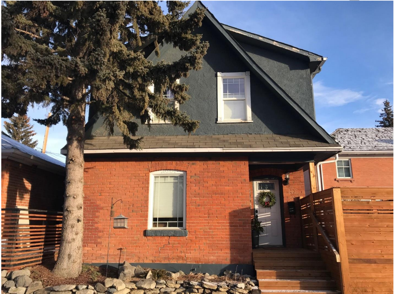
(Image 1.1: West façade)
