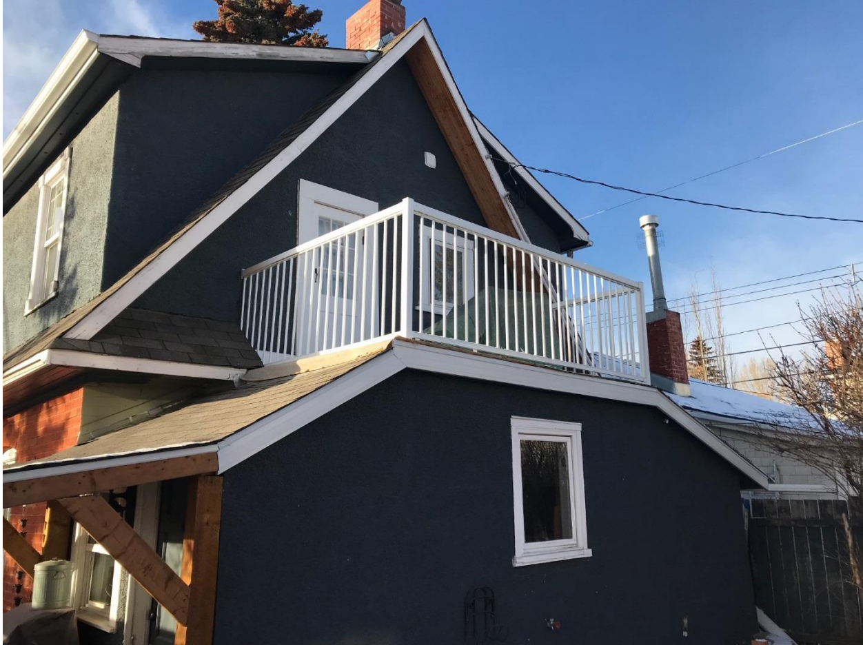
(Image 4.1: East façade)
