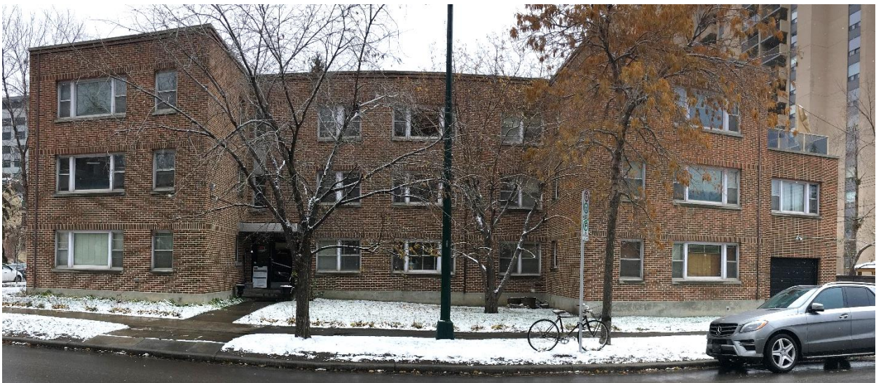
(Image 1.1: west façade)
