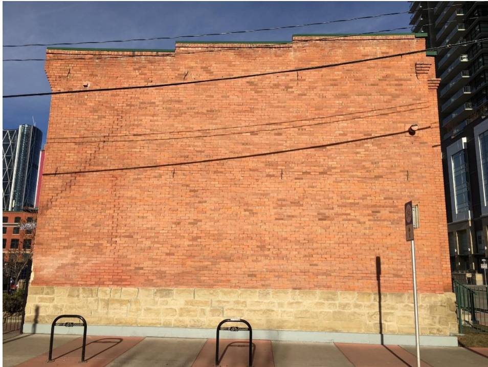
(Image 3.1 South Façade)
