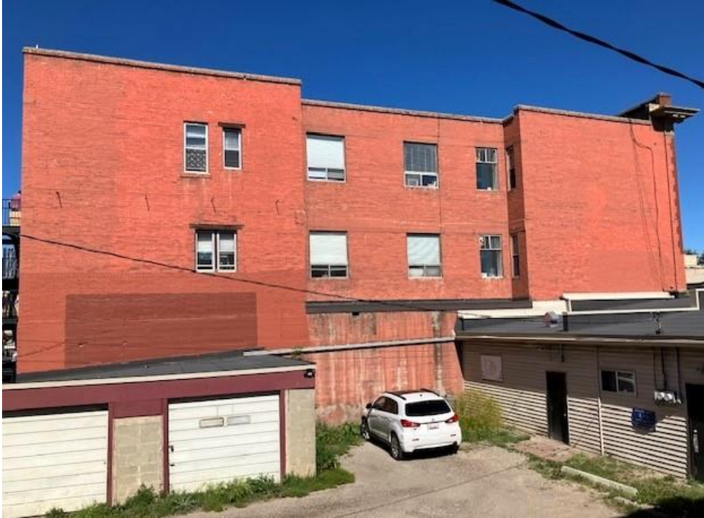
(Image 4.2: East façade)
