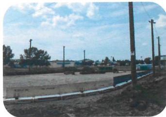
Ready for the concrete pour
