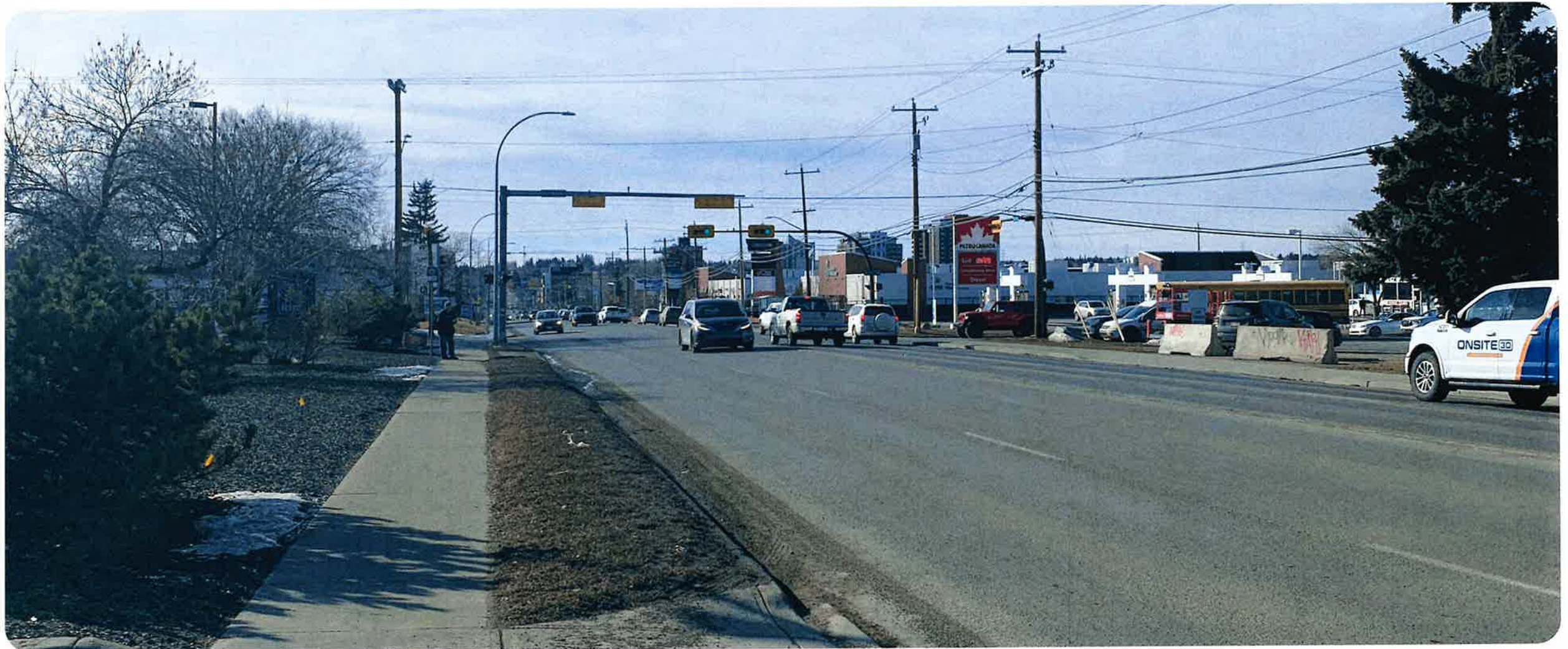
Subject Site (View west along 58 AV SE)
