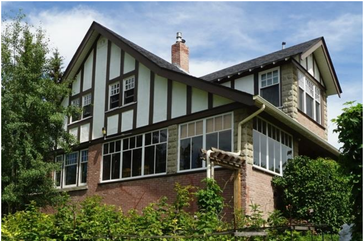
(Image 3.1: West façade)
