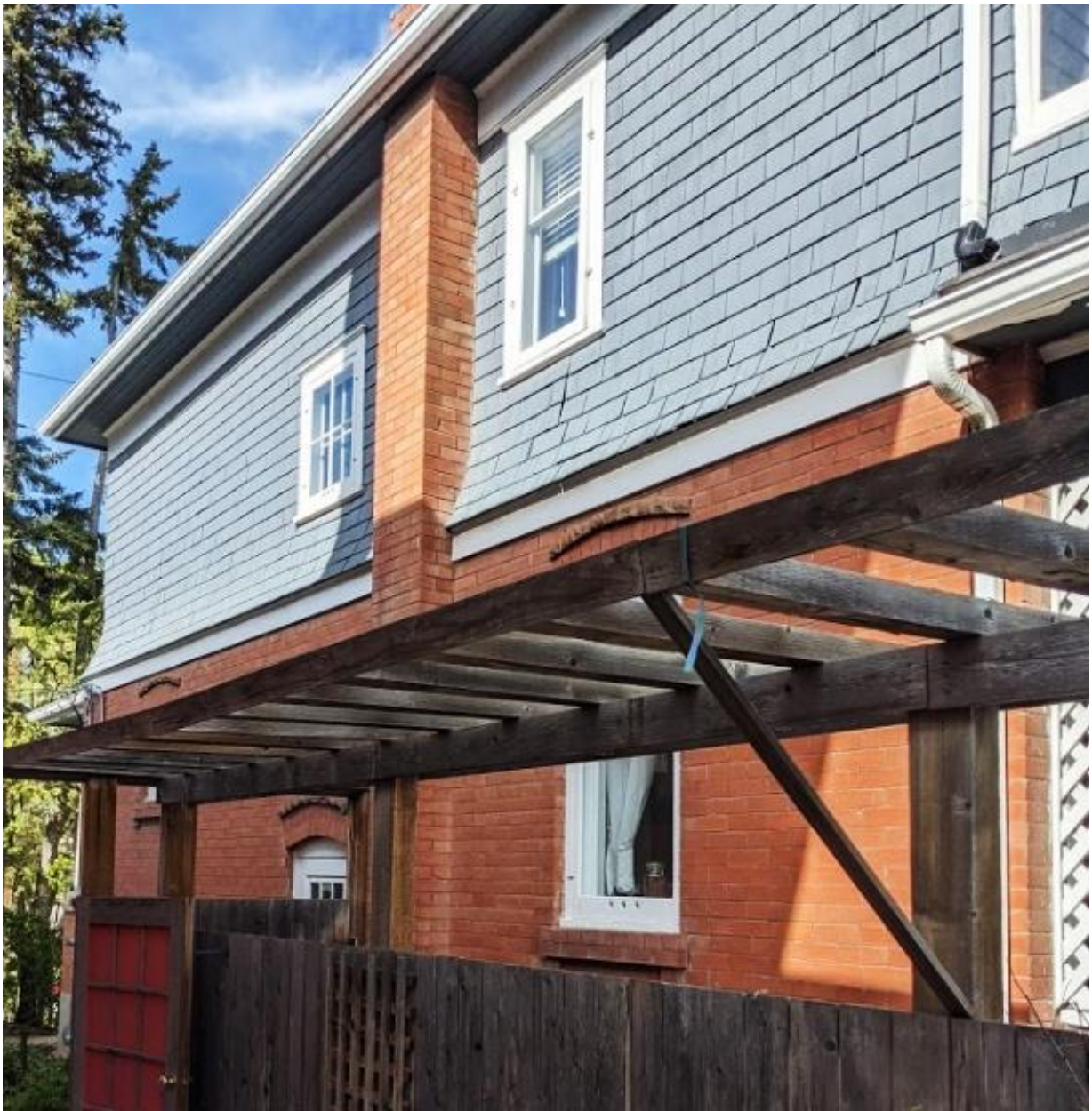
(Image 2.3: West façade)
