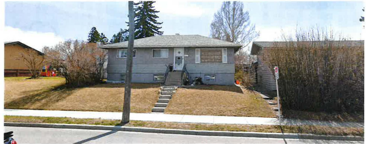
Subject Site – Looking South from 50 AV SW
