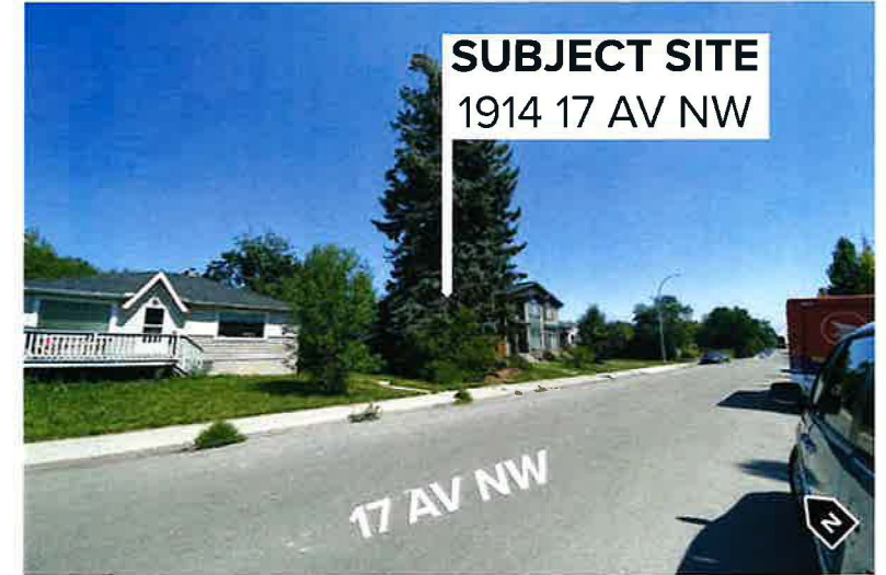
Looking East from 17 AV NW
