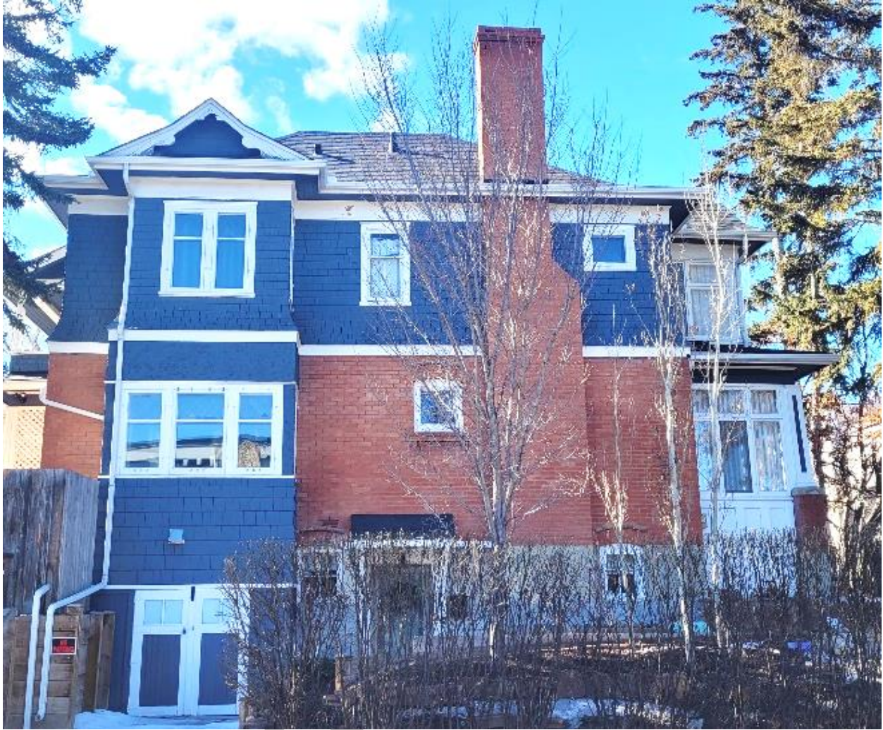
(Image 2.2: East façade)
