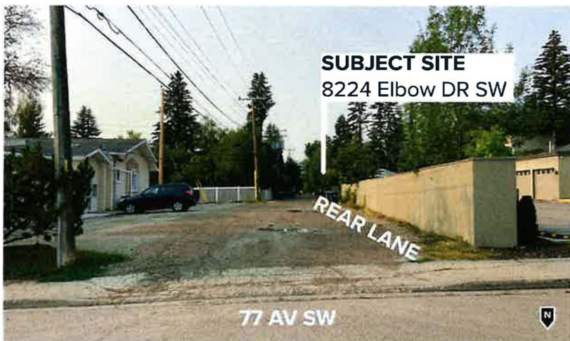
Rear lane entrance off 77 AV SW looking South
