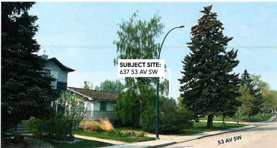
Looking southwest from 53 AV SW
