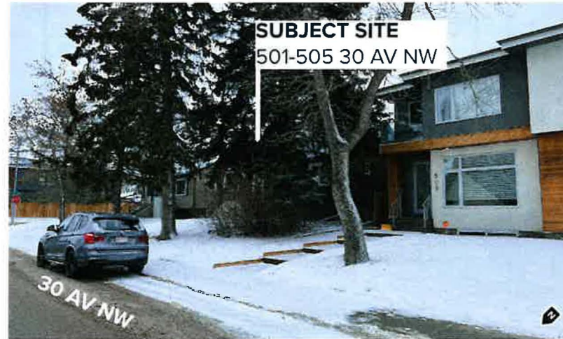
Looking Southeast from 30 AV NW
