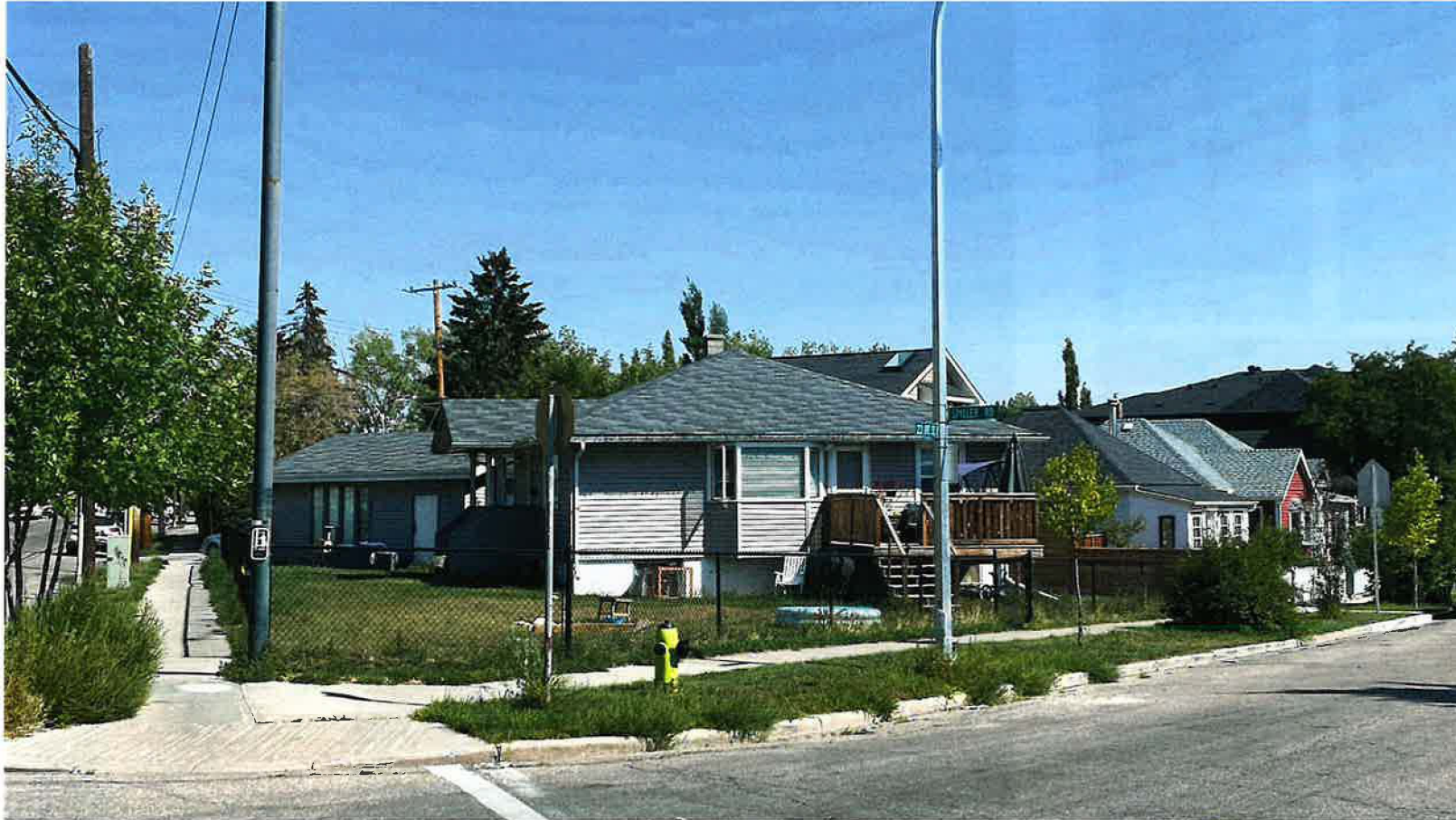
Front View form the corner of Spiller Road and 23 AV SE
