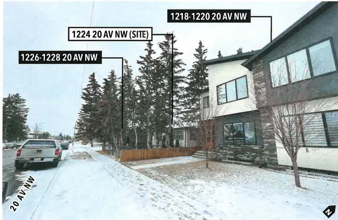
VIEW WEST ALONG 20 AV NW
