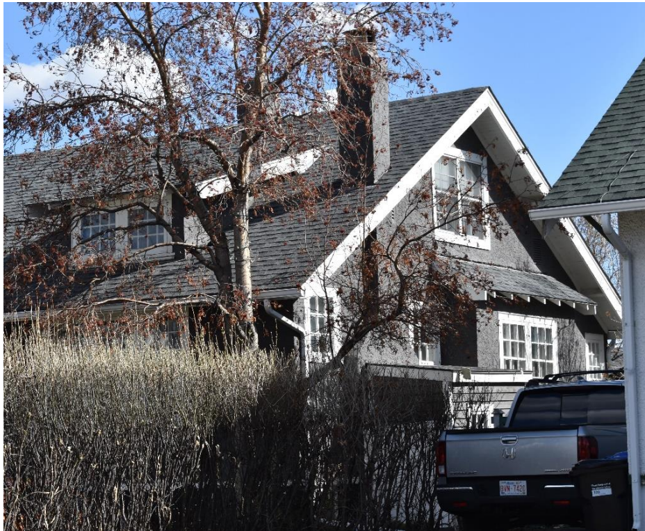
(Image 2.3: West façade)
