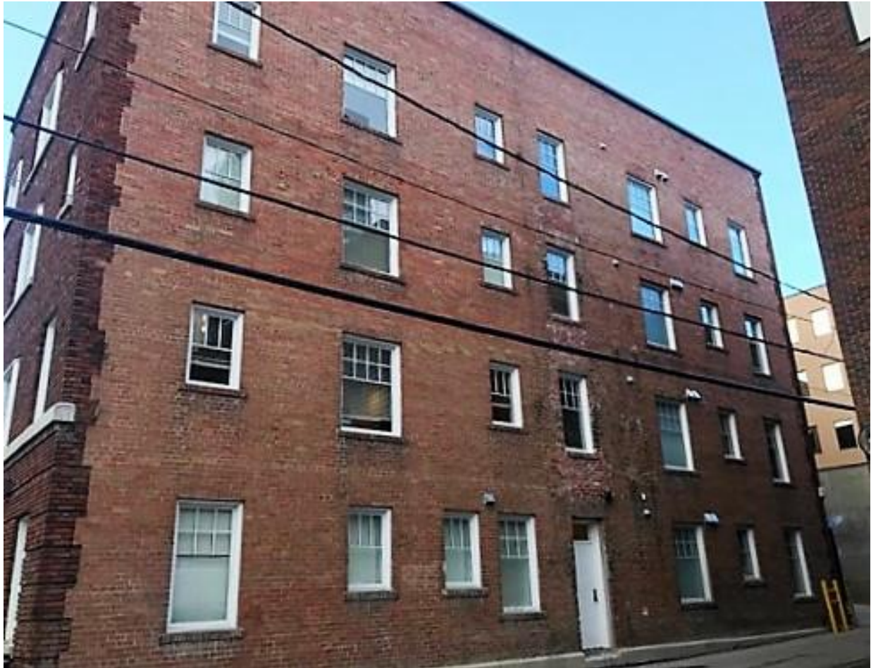
(Image 3.1: North façade)
