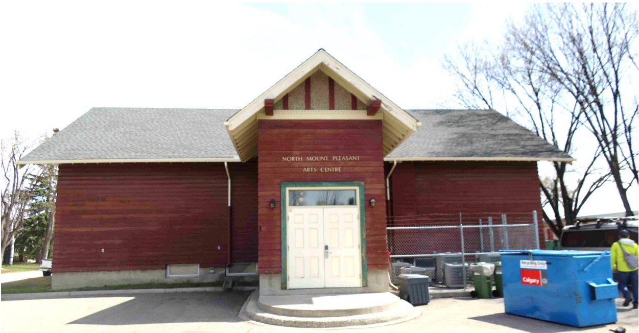
(Image 2.4: West façade)
