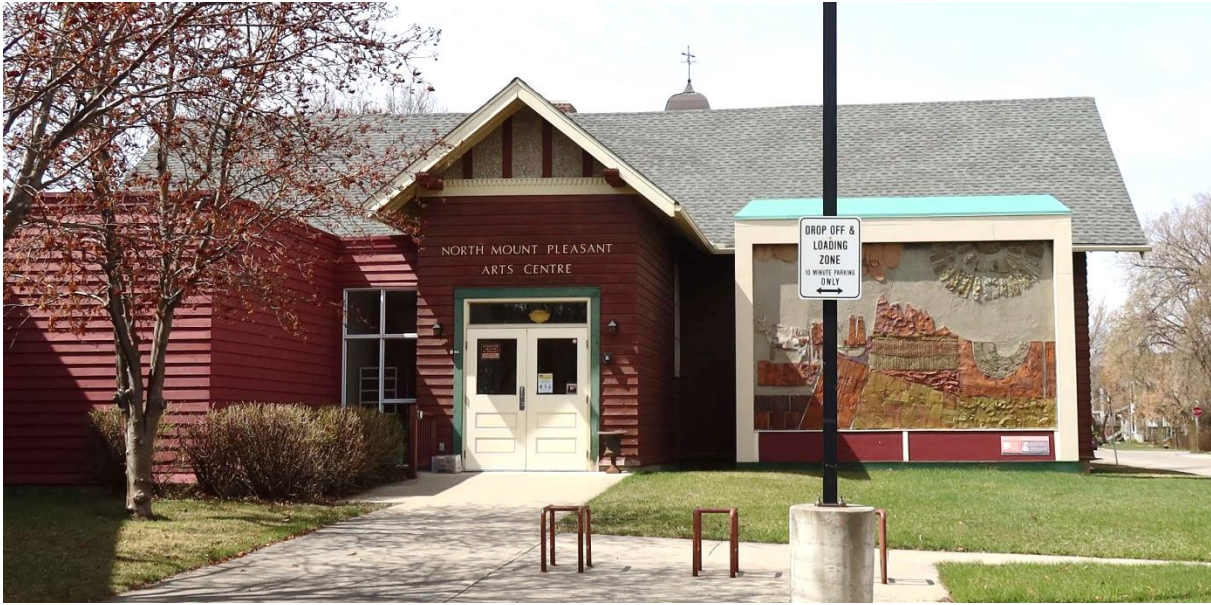
(Image 2.1: East façade)
