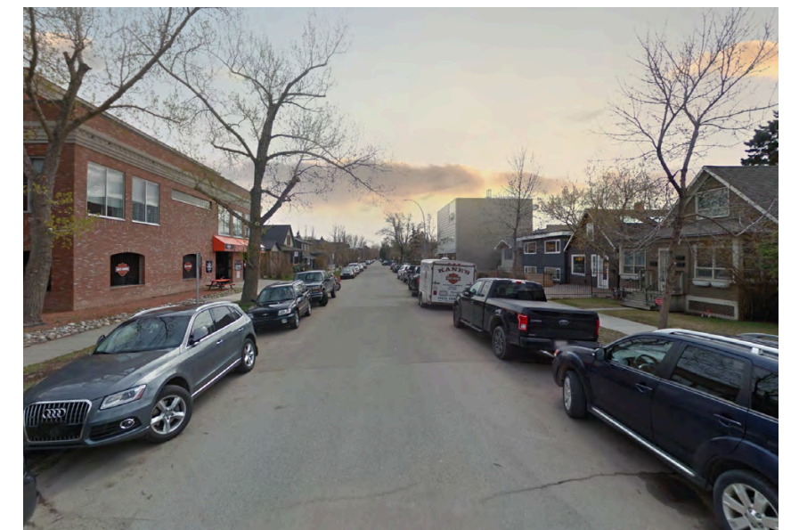
10 AV SE: Local Small Business & Festival Hall Looking East
