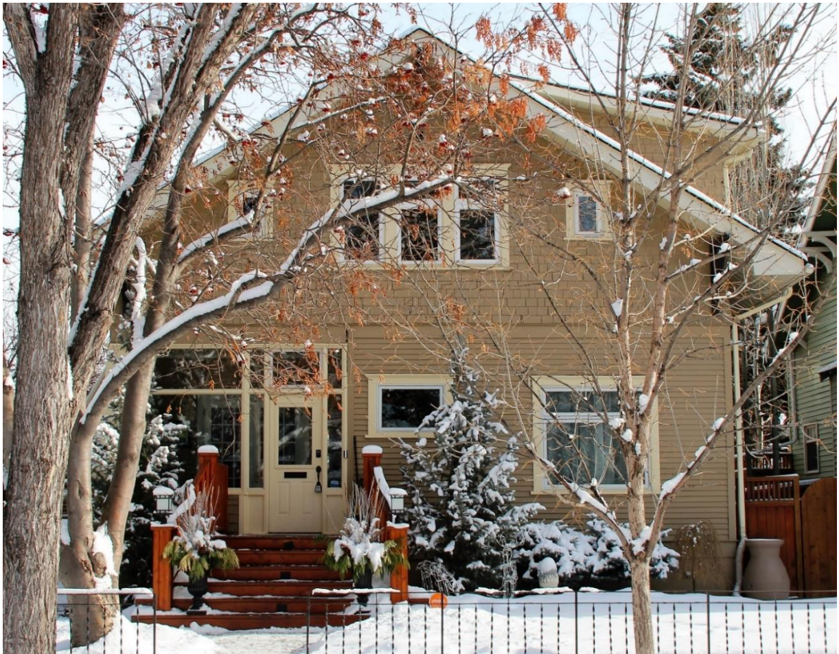
(Image 2.1: West façade)
