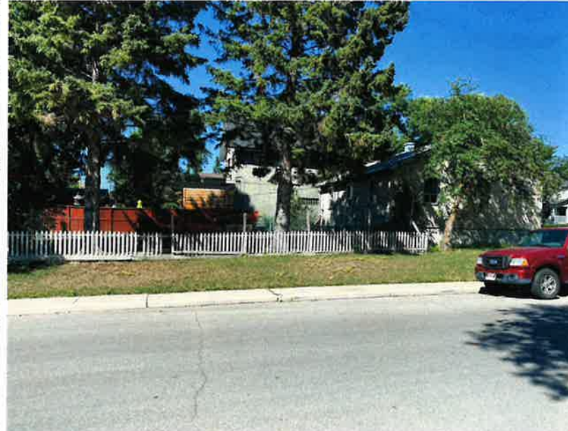
View from 23 AV SW
