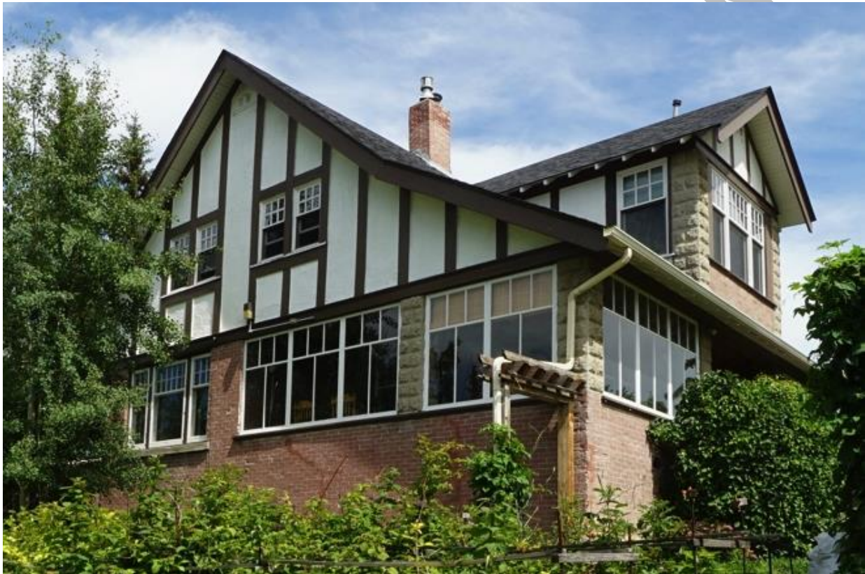
(Image 3.1: West façade)
