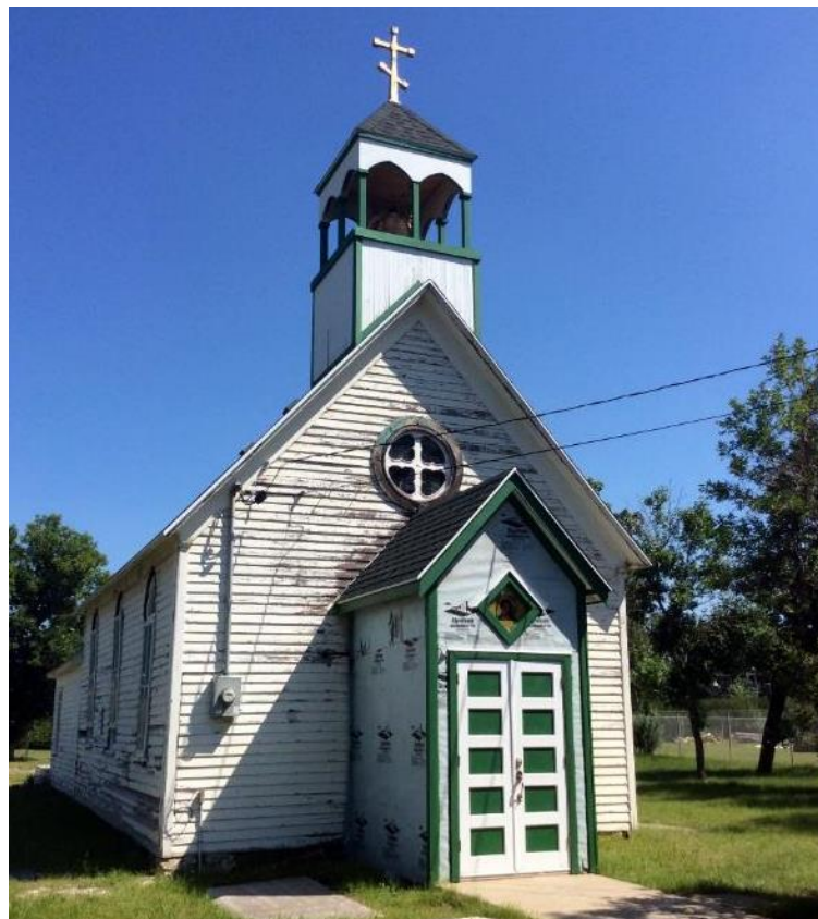
(Image 2.3: West façade)
