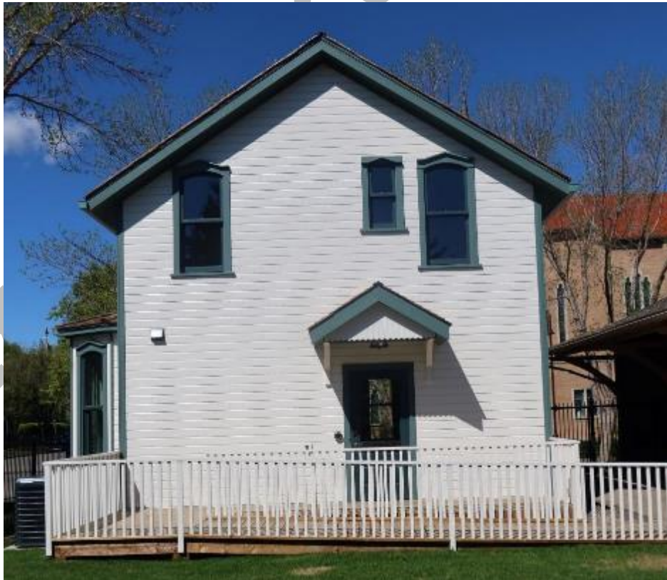
(Image 2.1: East façade)
