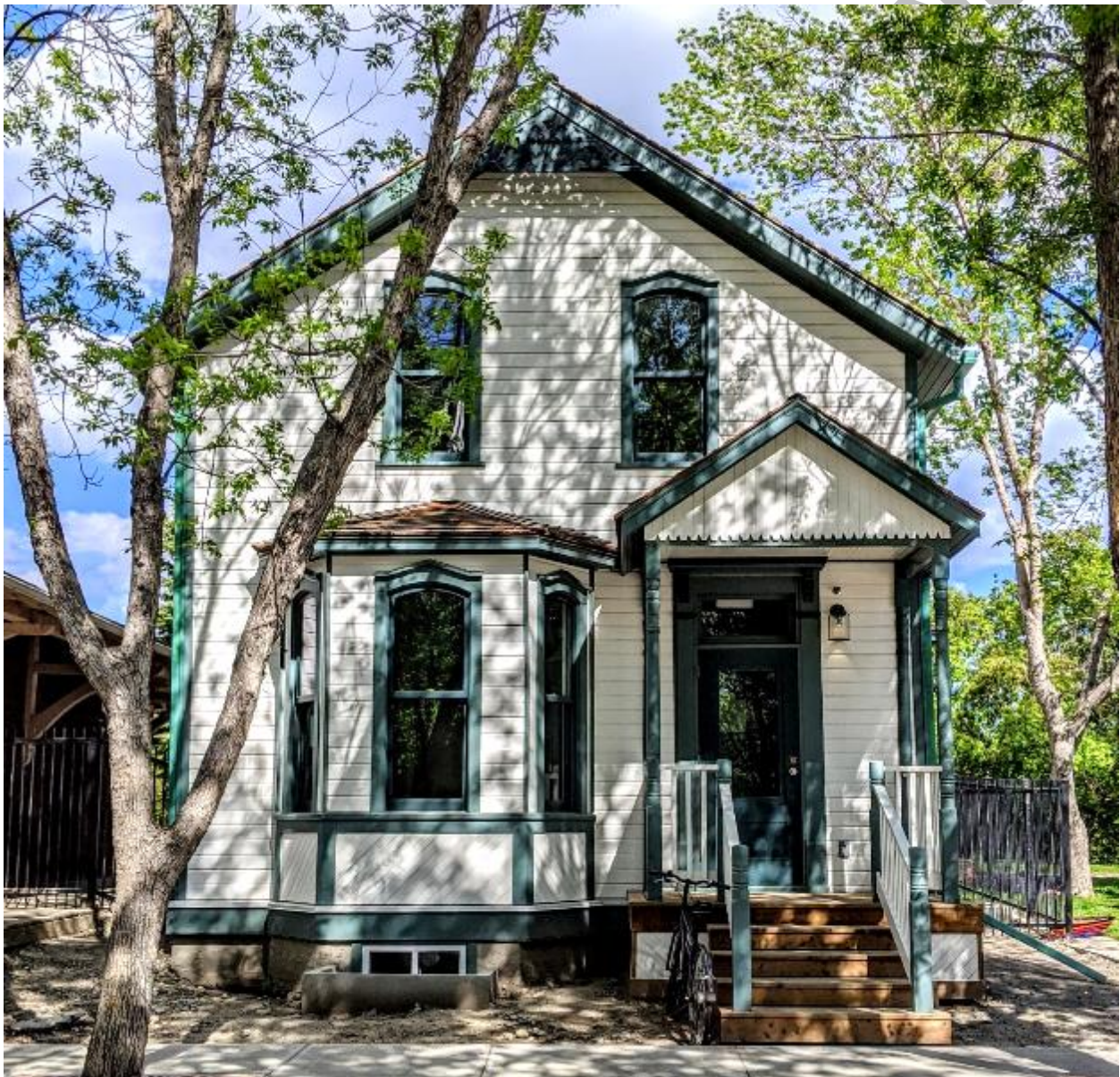
(Image 1.1: West façade)
