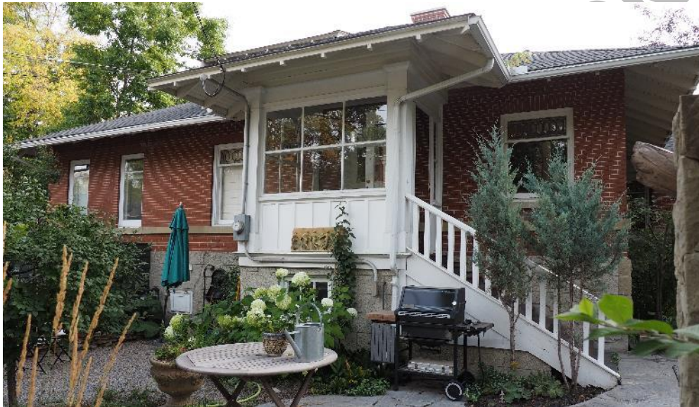
(Image 4.1: West façade)
