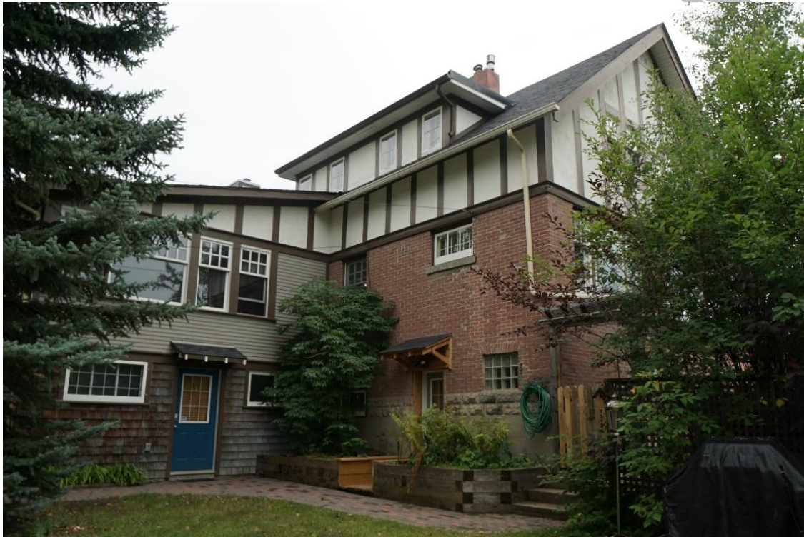
(Image 4.1: North façade)
