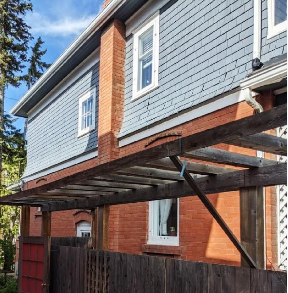
(Image 2.3: West façade)
